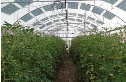
Gewächshaus mit integrierten Solarmodulen
